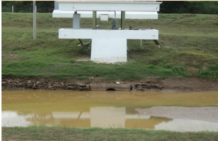
Figura 6. Estación de Bombeo de agua tomada en el río Sumapaz
