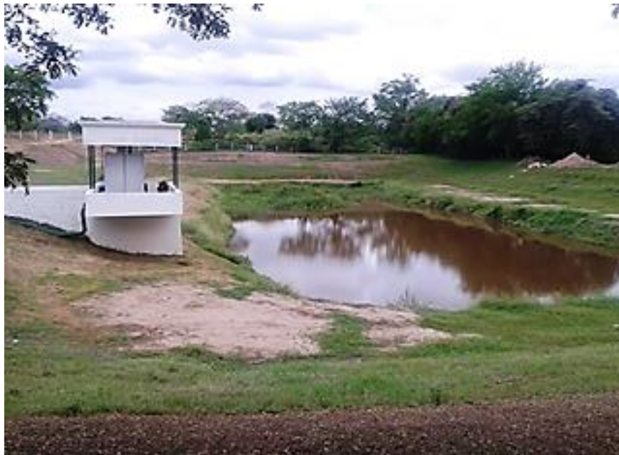
Figura 5. Laguna de agua cruda.
